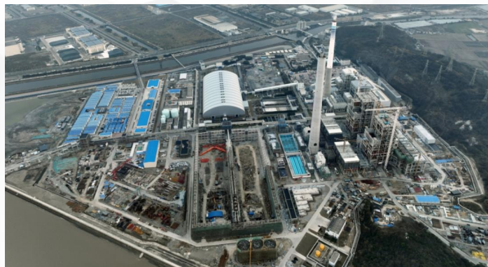
2023 浙江公司舟山电厂三期2×660MW扩建工程 BLOKSET 509台
