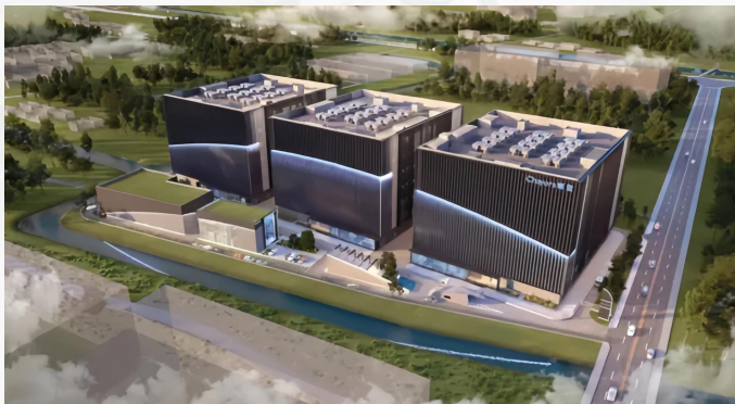
2025 朝亚太仓数据中心园区#3数据中心项目 BLOKSET 486台
