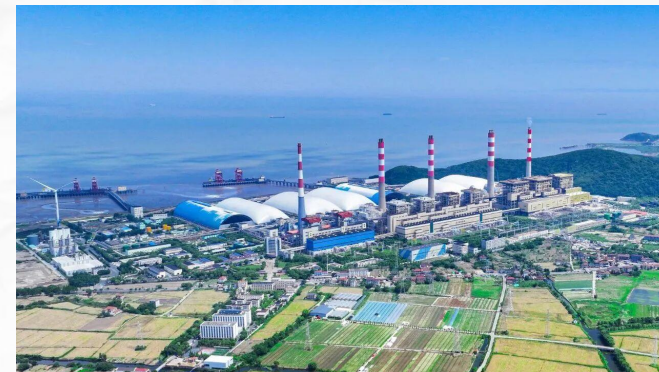
2025 浙能嘉兴电厂四期扩建项目 BLOKSET 486台
