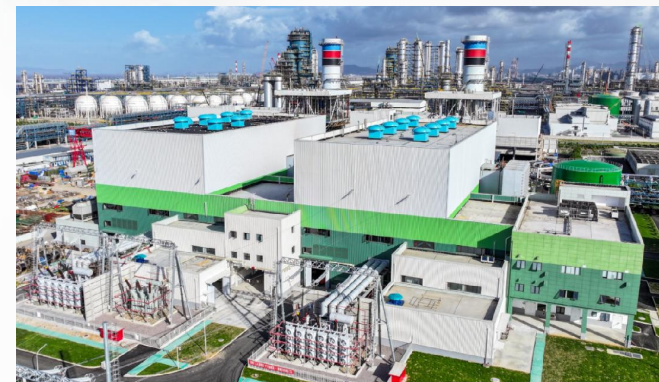
2023 浙能镇海天然气发电公司燃机搬迁改造项目 BLOKSET 188台
