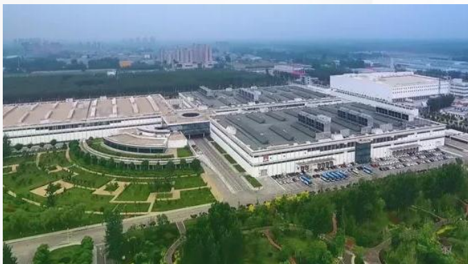
2025 廊坊市京云云计算中心项目 BLOKSET 276台
