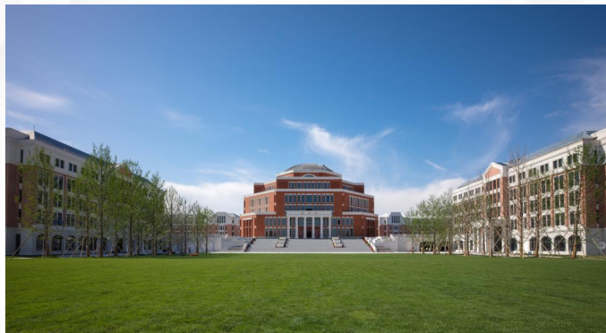
2025 宁波东方理工校园建设一期项目 BLOKSET 443台
